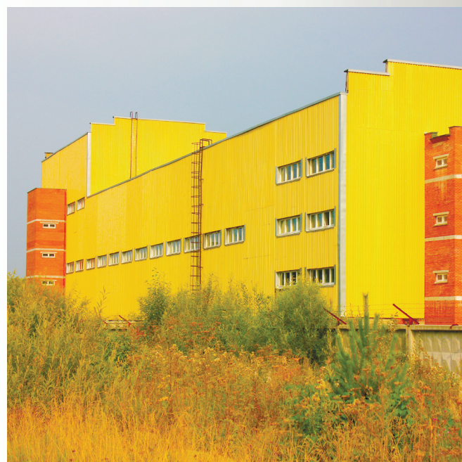
На снимке: очистные сооружения ФГУП «Комбинат «Электрохимприбор»
