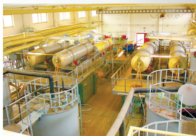
На снимке: Очистные сооружения
